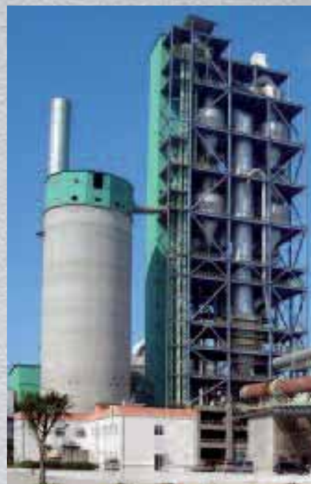
Der Wärmetauscher des neuen Zementwerks
